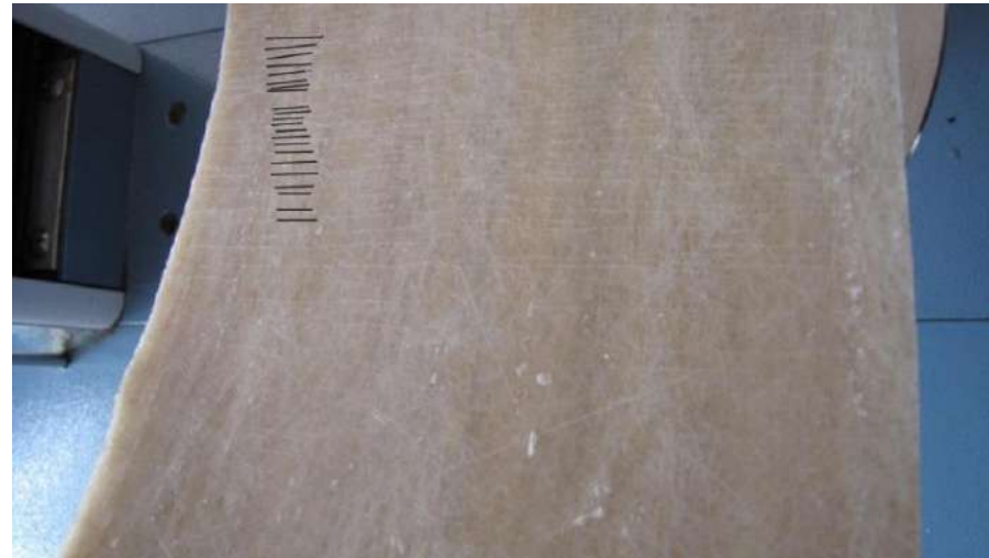
Трещины на поверхности образца гелькоуту образца стеклопластиковой трубы после 10% деформации. Начало трещин обозначено черным.
